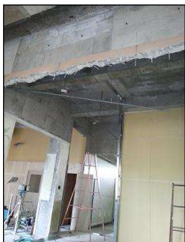
相談支援事業所「さくら」 改修工事の様子
