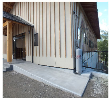
玄関スロープ
